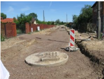
Przebudowa ulicy Pustej w Prabutach
